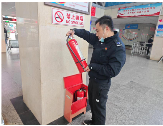
(安全员对站内消防设施进行检查)
